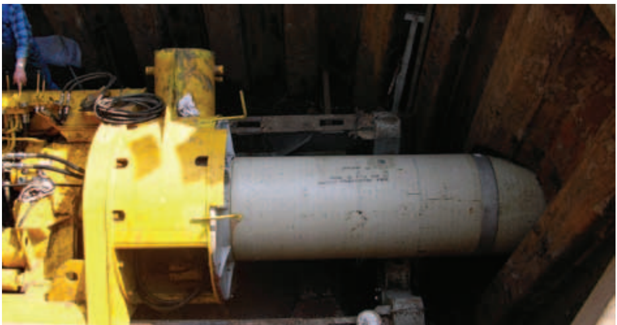
SCHRITT III – Eintrieb der AMIJACK CCGRP-Vortriebsrohre
